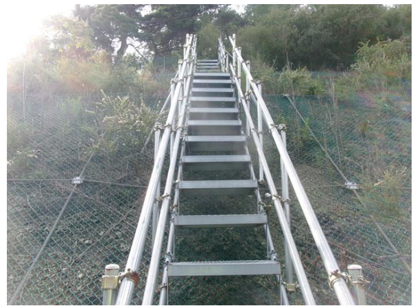
점검 사다리 전경
